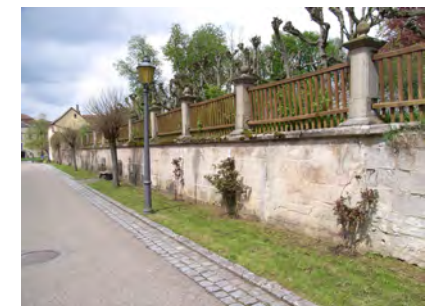
Mauer an der Schlossstraße
