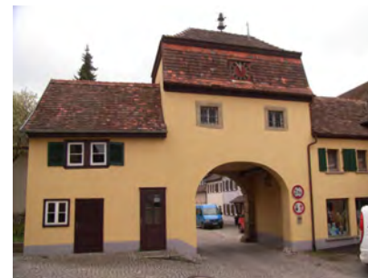
Ansicht von W
