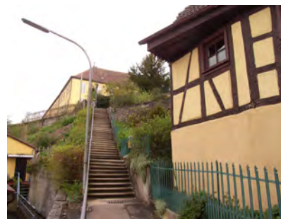
Ansicht nach W mit Treppe
