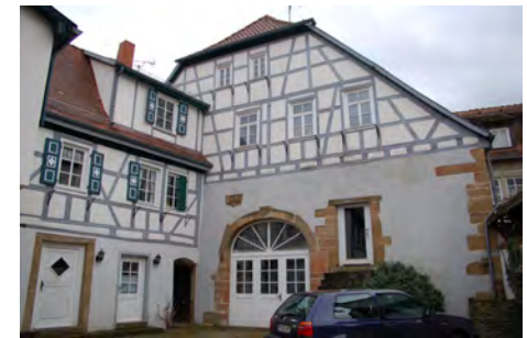
Ehemaliger Scheunenteil (❸)
