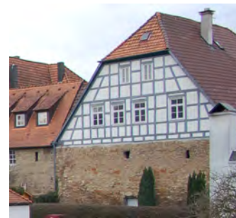
Ehem. Scheune auf Stadtmauer (❷)
