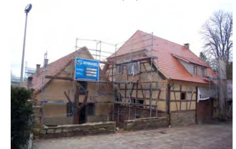
Scheune und Nebenhaus links (❸)
