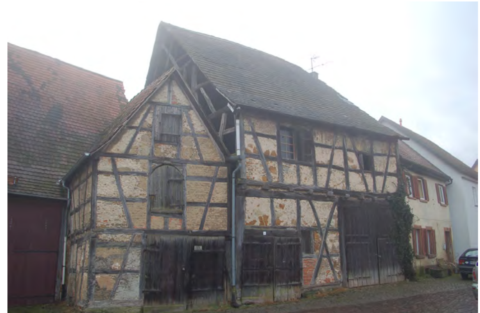
Rechte Scheune: Burgviertel 12 (links Burgviertel 14)
