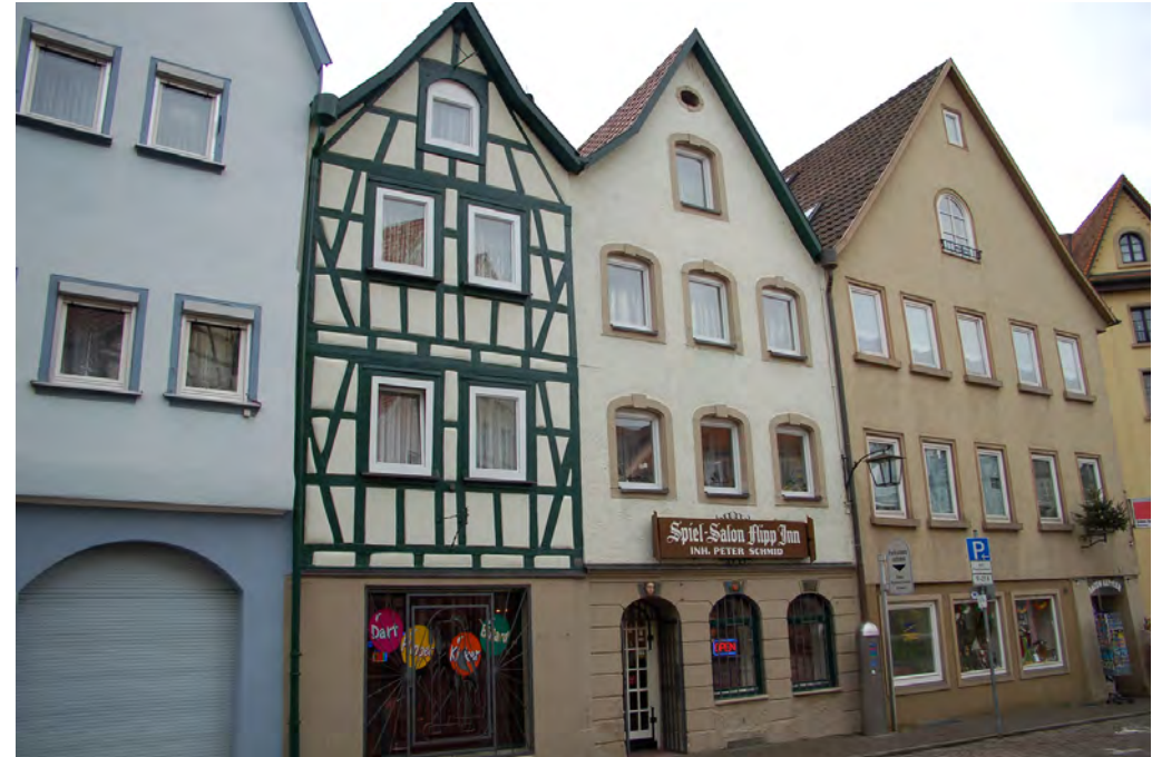
Westlicher Bau (❶) rechts, östlicher Bau (❷) links
