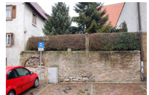
Seitliche Hofmauer mit Rundbogen-Kellertor
