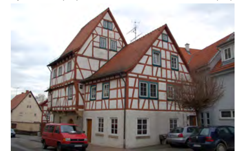
Haupthaus mit südlichem Anbau (❸)
