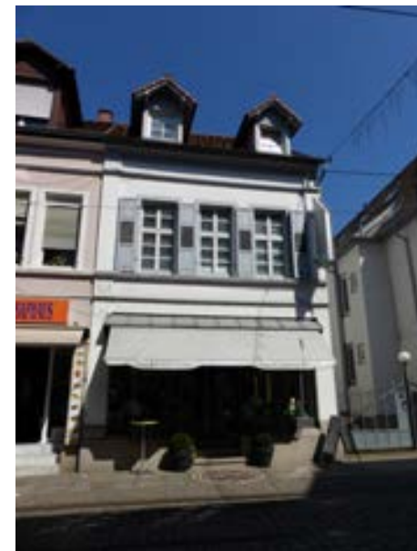
Karlsruhe-Durlach, Pfinztalstraße 82 v. S
