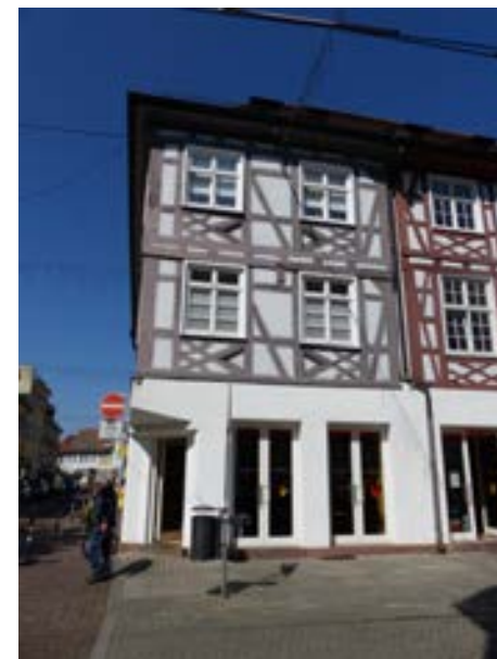
Karlsruhe-Durlach, Pfinztalstraße 54 v. S
