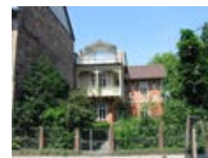
Ansicht von Südost (Vorderseite)
