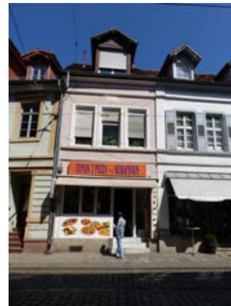
Karlsruhe-Durlach, Pfinztalstraße 84 v. S
