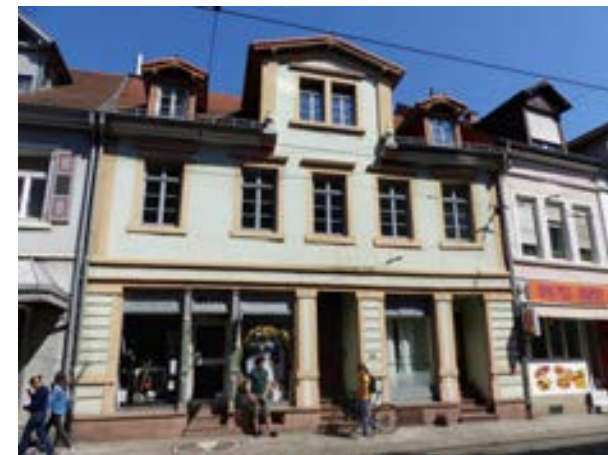
Karlsruhe-Durlach, Pfinztalstraße 86 v. S
