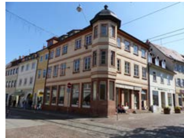
Karlsruhe-Durlach, Pfinztalstraße 29 von NW
