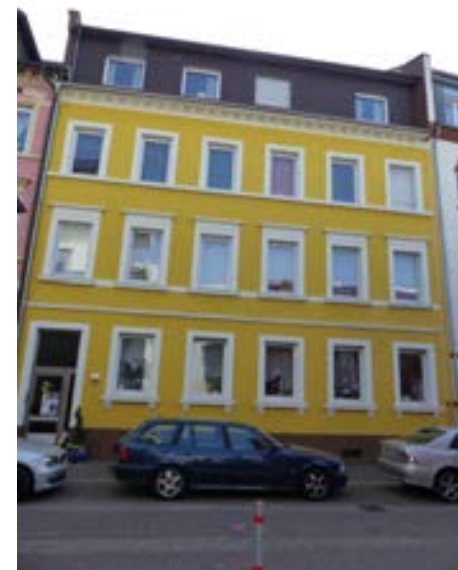
Karlsruhe-Durlach, Seboldstraße 16 von NW
