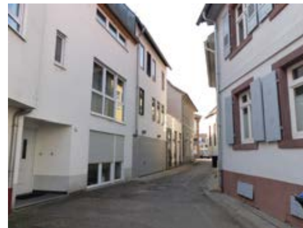
Karlsruhe-Durlach, Bäderstraße nach W
