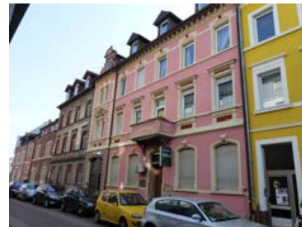
Karlsruhe-Durlach, Seboldstraße 18 v. N
