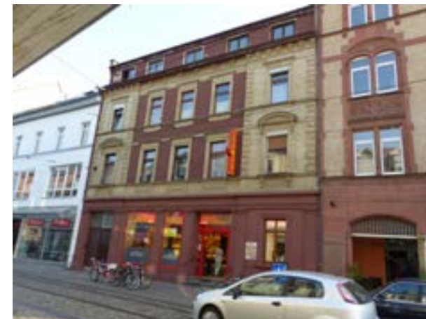
Karlsruhe-Durlach, Pfinztalstraße 67 v. NW
