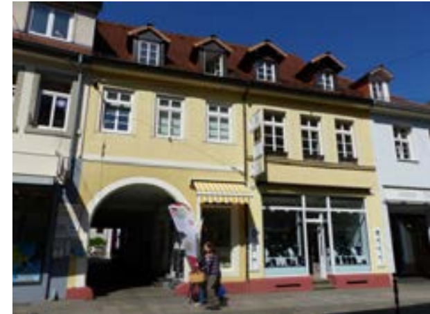
Karlsruhe-Durlach, Pfinztalstraße 40, 42 v. S
