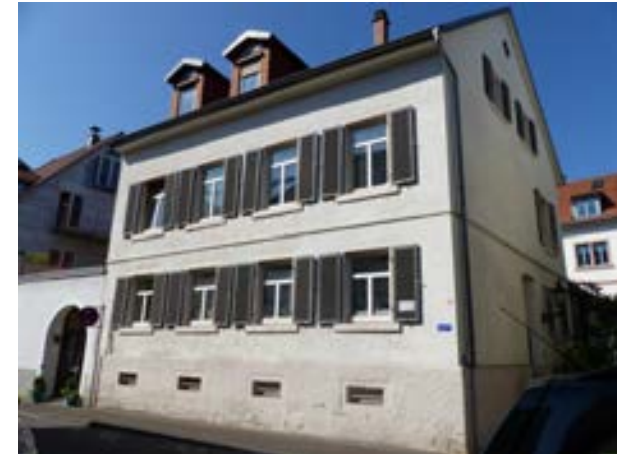
Karlsruhe-Durlach, Ochsantorstraße 5 v. NO
