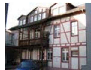
Am Zwinger 15, Seitengebäude, Fassade
