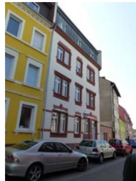
Karlsruhe-Durlach, Seboldstraße 14 v. N
