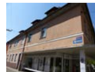
Pfinztalstraße 49 Fassade Mittelstraße
