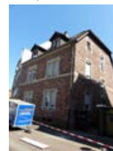
Seboldstraße 24 v. N W
