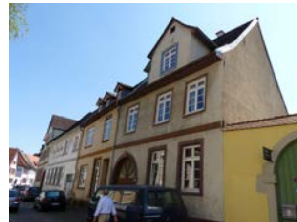
Karlsruhe-Durlach, Bienleinstorstraße 32 von NW
