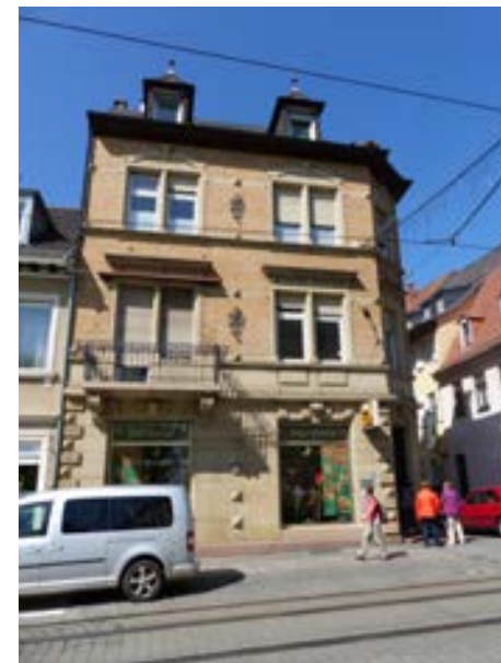
Karlsruhe-Durlach, Pfinztalstraße 12 von S
