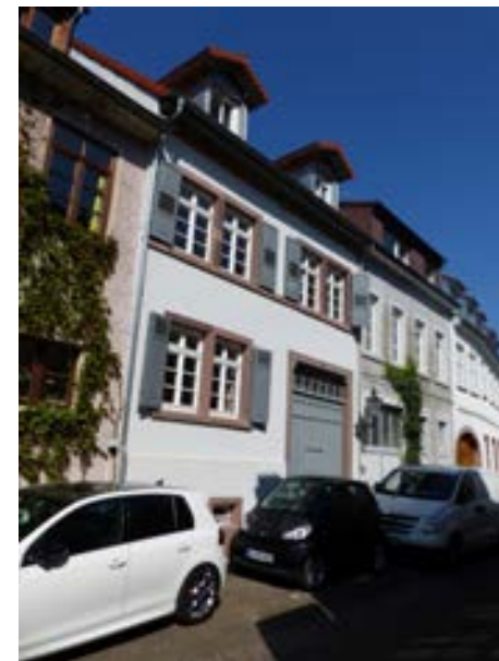
Karlsruhe-Durlach, Rappenstraße 9 v. SO
