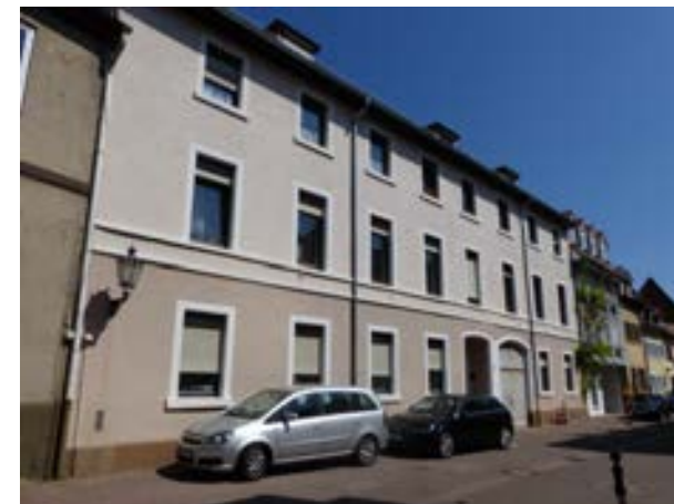
Karlsruhe-Durlach, Spitalstraße 16 sv. SW
