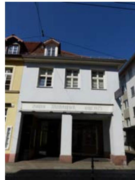
Karlsruhe-Durlach, Pfinztalstraße 38 v. S
