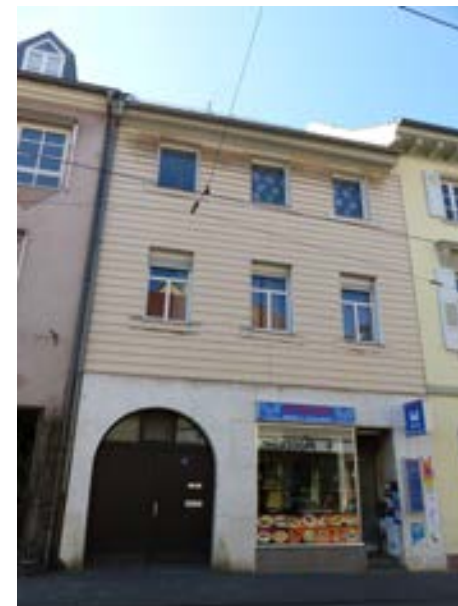
Karlsruhe-Durlach, Pfinztalstraße 5 v. NW
