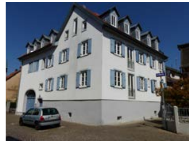
Karlsruhe-Durlach, Kelterstraße 29 von S
