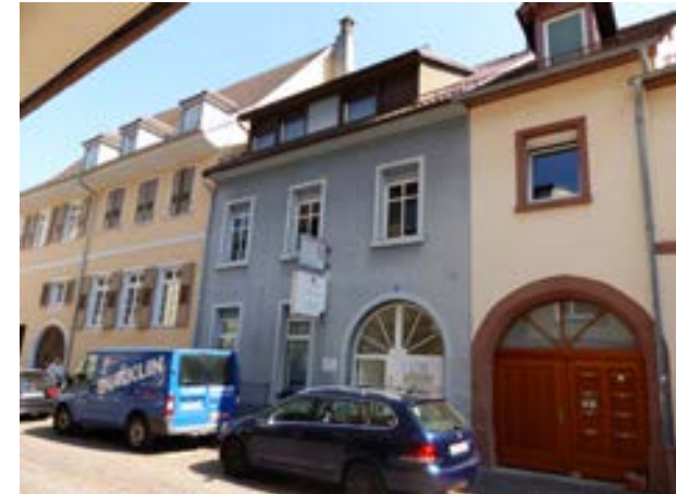
Karlsruhe-Durlach, Kelterstraße 3 v. SW
