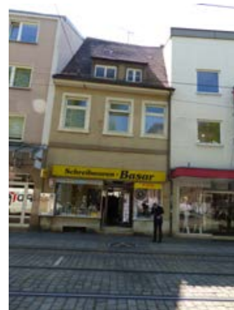
Karlsruhe-Durlach, Pfinztalstraße 55 von N
