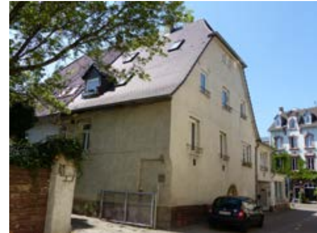
Karlsruhe-Durlach, Spitalstraße 25,27 v. SO
