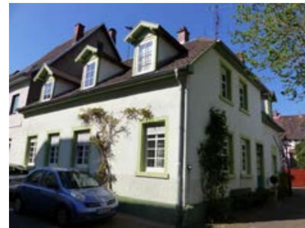
Karlsruhe-Durlach, Jägerstraße 13 v. NO
