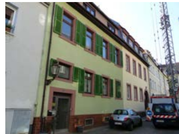
Karlsruhe-Durlach, Jägerstraße 6 v. NW
