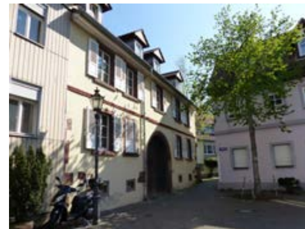
Karlsruhe-Durlach, Jägerstraße 48a v. SW
