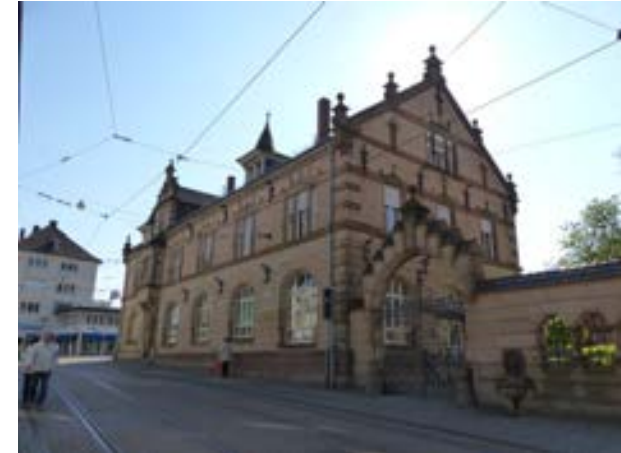
Karlsruhe-Durlach, Pfinztalstraße 1 von W
