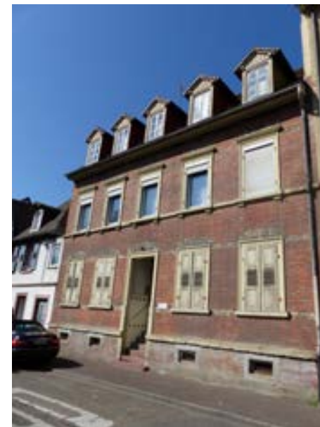
Karlsruhe-Durlach, Ochsantorstraße 19 v. NO
