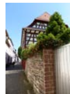
An der Stadtmauer 10 von W
