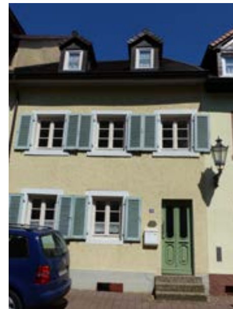
Karlsruhe-Durlach, Spitalstraße 10 v. SW
