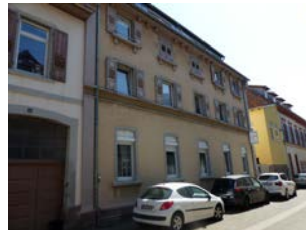
Karlsruhe-Durlach, Zehntstraße 4 v. NW
