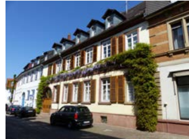
Karlsruhe-Durlach, Amthausstraße 22 von SO
