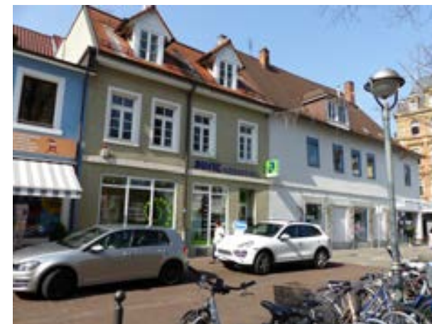
Karlsruhe-Durlach, Marstallstraße 2, 4 v. SO
