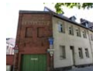
Bienleinstorstraße 30, Saalbau v. NO
