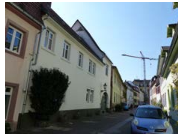
Karlsruhe-Durlach, Jägerstraße 20 v. NW
