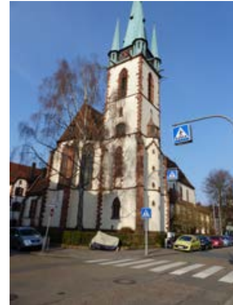
Karlsruhe--Durlach, Kanzlerstraße 2 v. W
