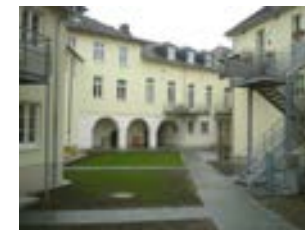
Innenhof nach Sanierung
