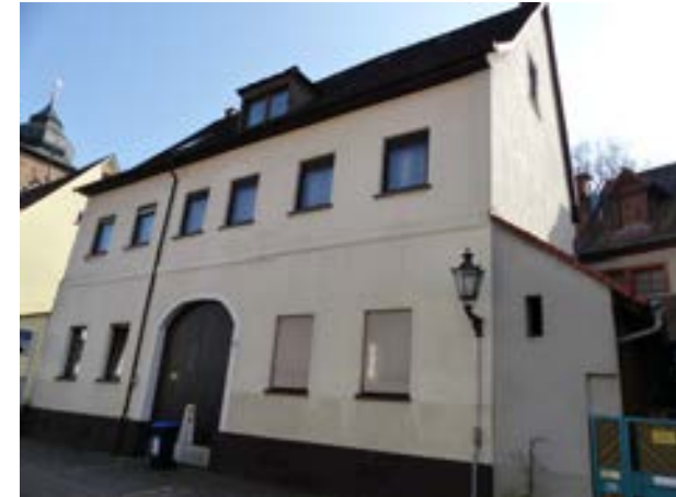
Karlsruhe-Durlach, Kelterstraße 30 v. NW
