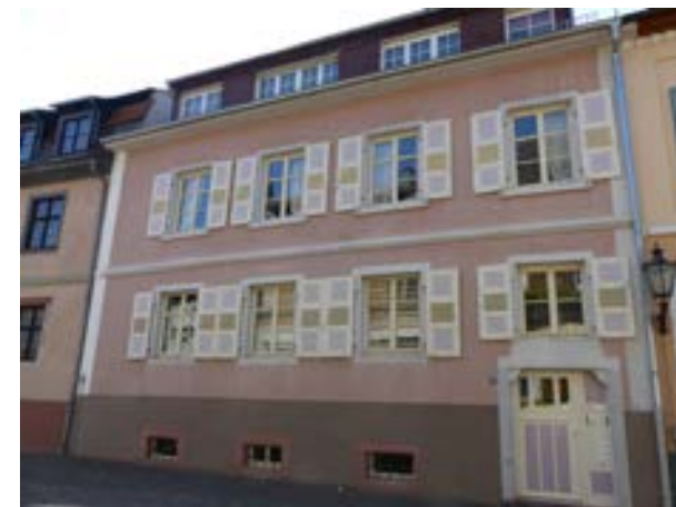
Karlsruhe-Durlach, Amthausstraße 27, v. NW
