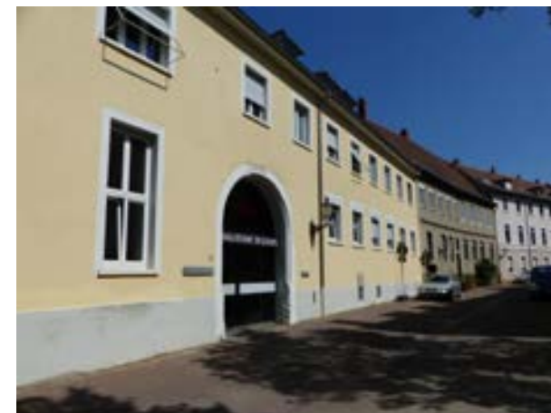
Karlsruhe-Durlach, Spitalstraße 20 v. SW
