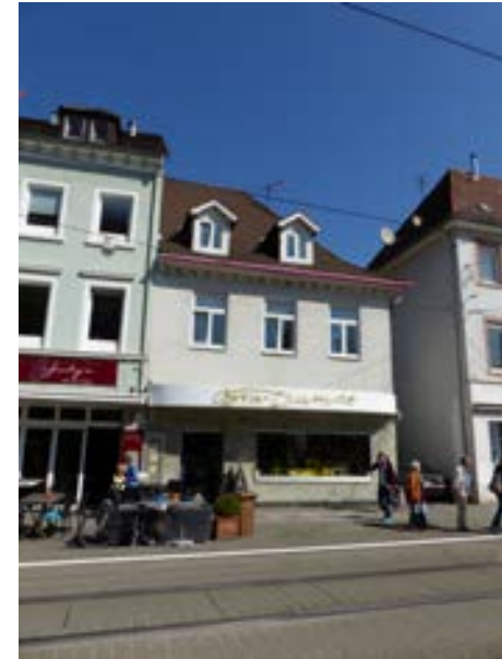
Karlsruhe-Durlach, Pfinztalstraße 20 v. S
