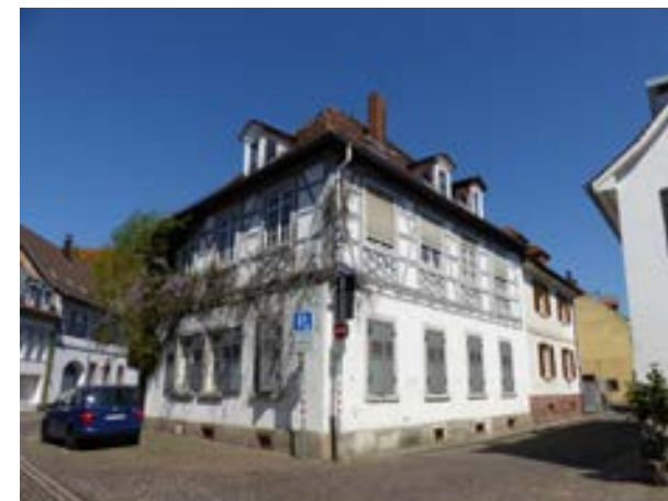
Karlsruhe-Durlach, Kelterstraße 23 v. NW
