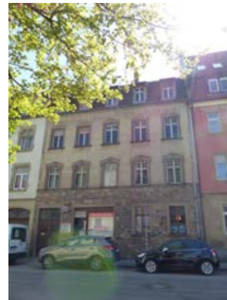
Karlsruhe-Durlach, Pfinzstraße 71 v. S
