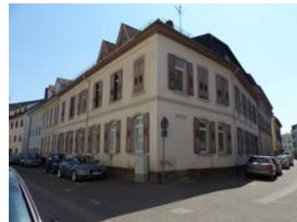
Karlsruhe-Durlach, Zehntstraße 6 v. NW
