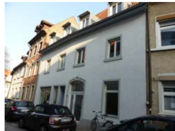
Karlsruhe-Durlach, Bienleinstorstraße 24 v. W
