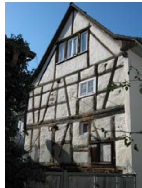
Karlsruhe-Durlach, Jägerstr. 8, Seitenflügel, O-Fassade
