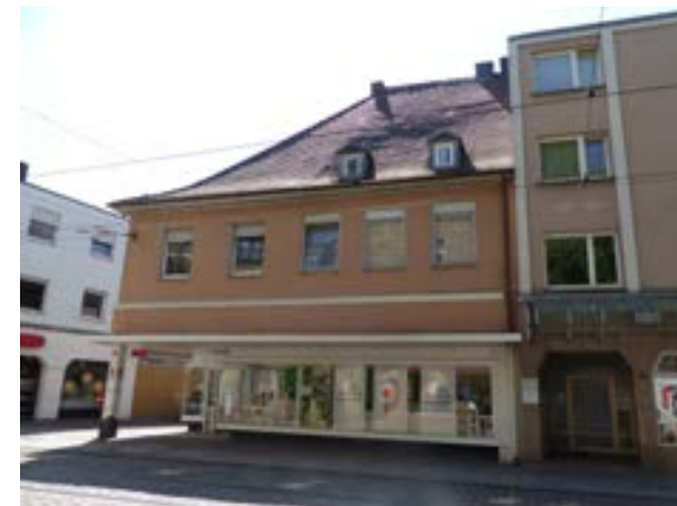
Karlsruhe-Durlach, Pfinztalstraße 49 v. NW
