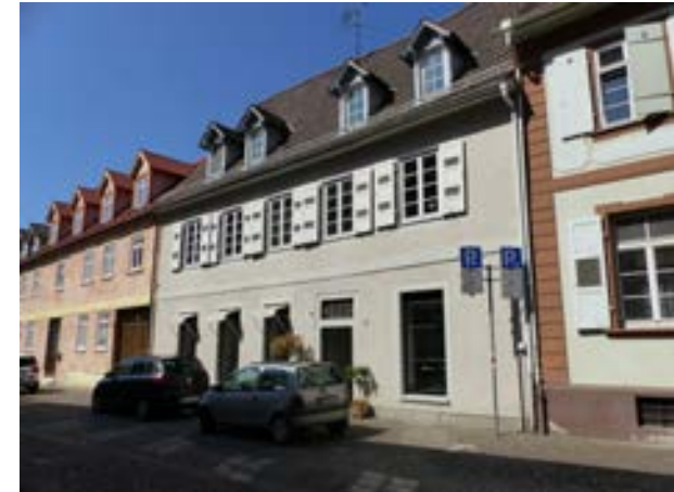
Karlsruhe-Durlach, Amthausstraße 2, v. NO
