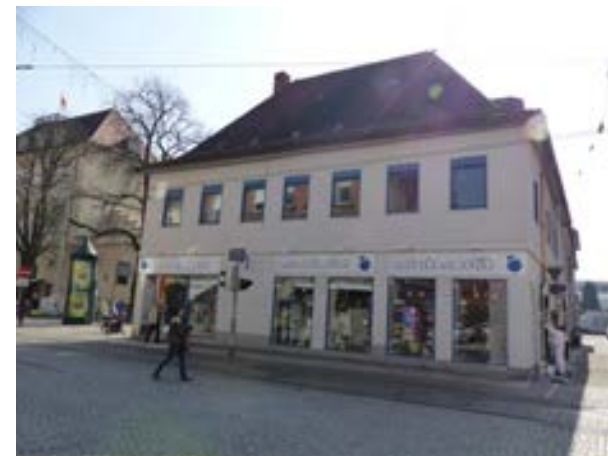
Karlsruhe-Durlach, Pfinztalstraße 11 von N
