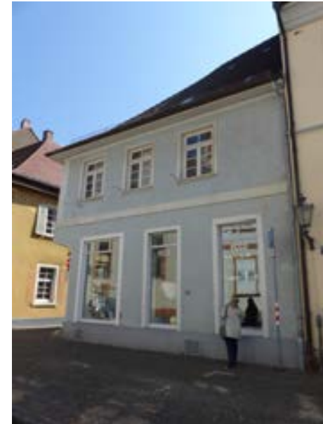
Karlsruhe-Durlach, Amthausstraße 9, v. SW
