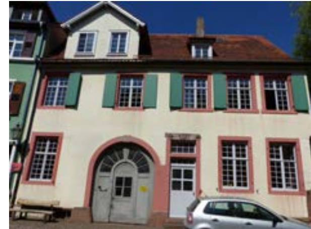
Karlsruhe-Durlach, Bienleinstorstraße 39 v. SW
