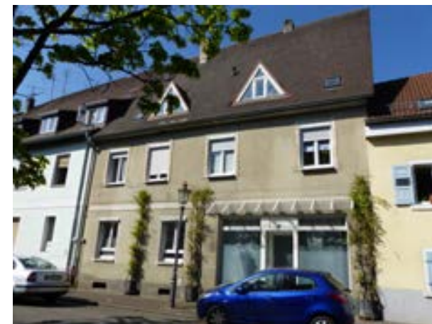
Karlsruhe-Durlach, Ochsantorstraße 13 v. NO
