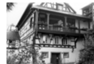
Gesindehaus mit Galerie
