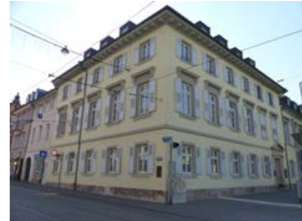
Karlsruhe-Durlach, Pfinztalstraße 7 v. NW
