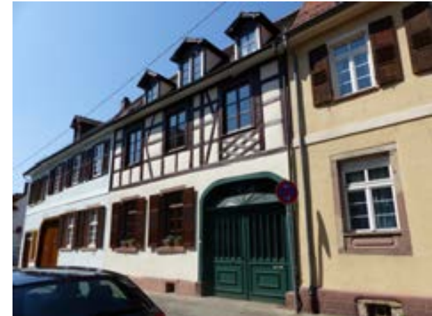
Karlsruhe-Durlach, Mittelstraße 16, 18 von SO
