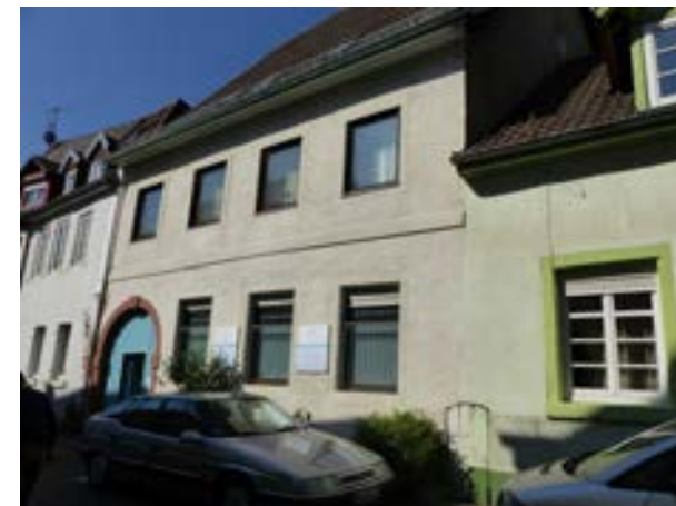
Karlsruhe-Durlach, Jägerstraße 11 v. NO
