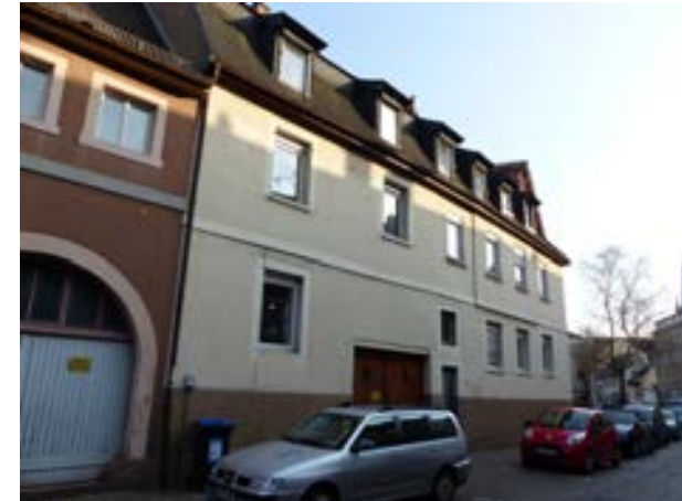
Karlsruhe-Durlach, Bienleinstorstraße 2 von NW
