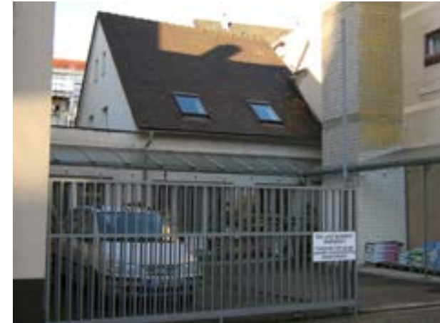
Karlsruhe-Durlach, Kelterstr. 2, Hinterhaus, O-Fassade
