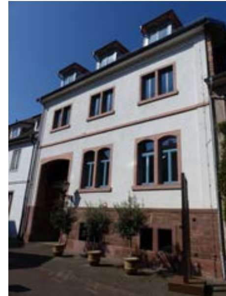
Karlsruhe-Durlach, Rappenstraße 5 v. O
