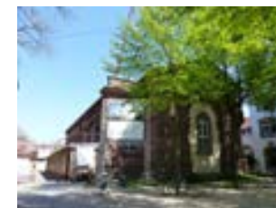
Pfinztalstraße 78 v. SW, Turnhalle
