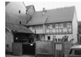
Nebengebäude links, alter Zustand
