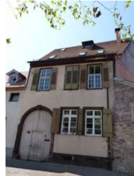
Karlsruhe-Durlach, Kelterstraße 22 v. NW
