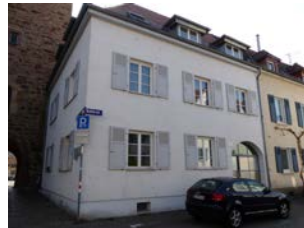
Karlsruhe-Durlach, Kelterstraße 38 v. SO
