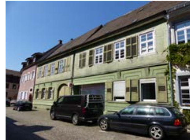
Karlsruhe-Durlach, Amthausstraße 16, v. SO
