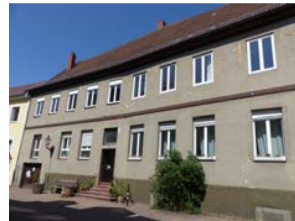
Karlsruhe-Durlach, Spitalstraße 18 v. SO
