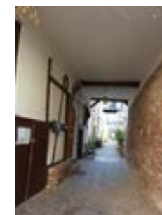
Zugang zu Jägerstraße 24 durch Torfahrt von Nr. 32
