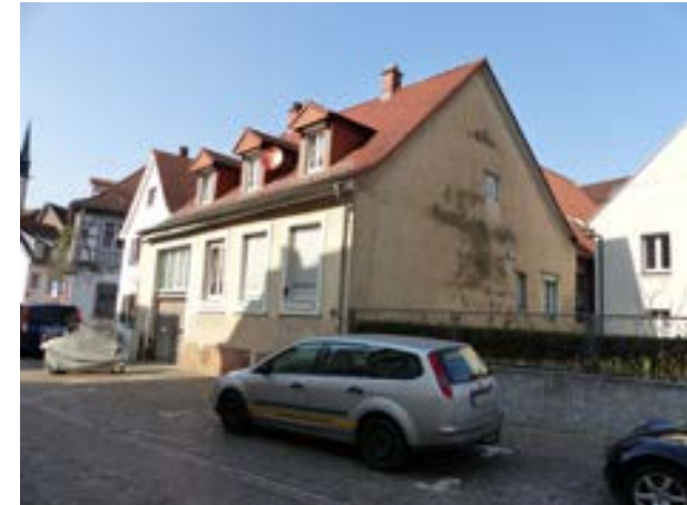
Karlsruhe-Durlach, Kelterstraße 25 v. SO
