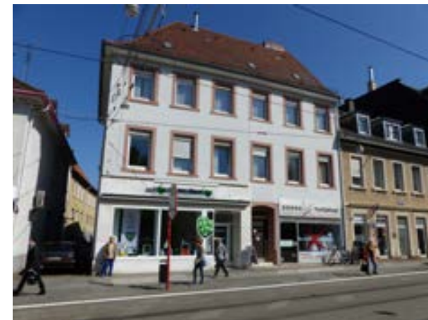
Karlsruhe-Durlach, Pfinztalstraße 16 von S
