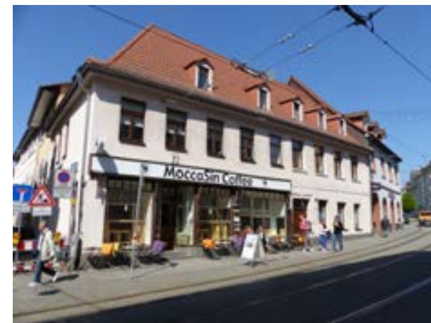
Karlsruhe-Durlach, Pfinztalstraße 10 v. S
