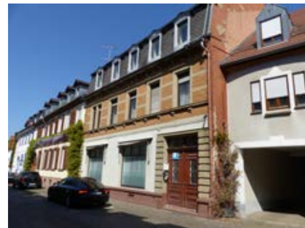
Karlsruhe-Durlach, Amthausstraße 20, v. SO
