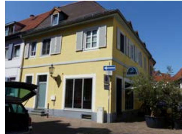
Karlsruhe-Durlach, Spitalstraße 2 v. SO
