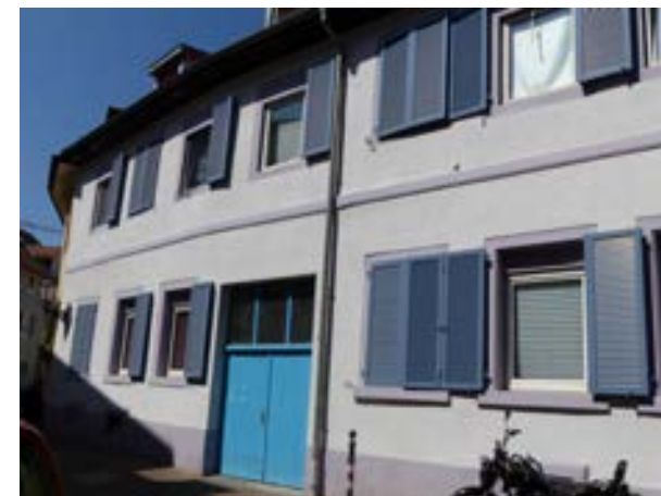
Karlsruhe-Durlach, Spitalstraße 4 v. SO
