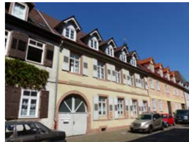
Karlsruhe-Durlach, Amthausstraße 6, v. SO
