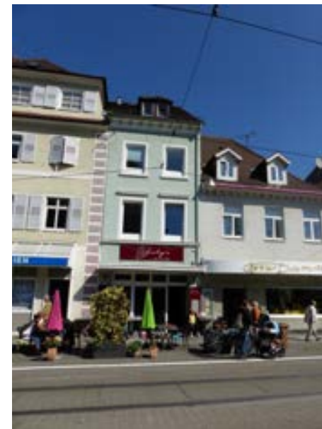
Karlsruhe-Durlach, Pfinztalstraße 22 v. S
