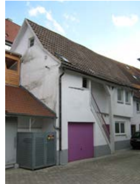
Karlsruhe-Durlach, Pfinztalstraße 44, Hofseite
