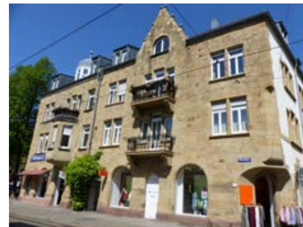
Karlsruhe-Durlach, Pfinztalstraße 76 v. S
