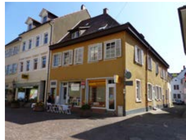
Karlsruhe-Durlach, Amthausstraße 7, v. SW
