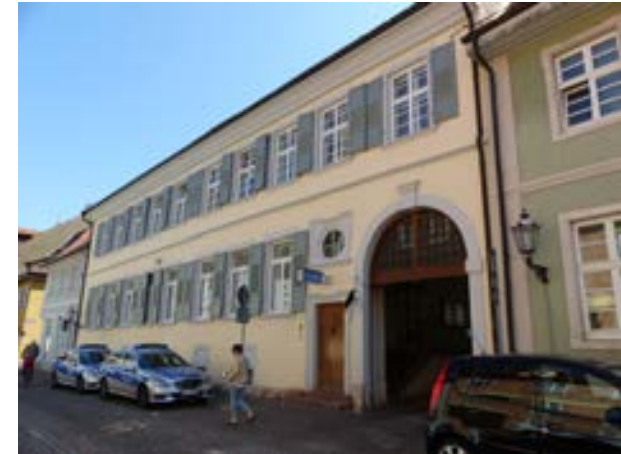
Karlsruhe-Durlach, Amthausstraße 11, v. SW
