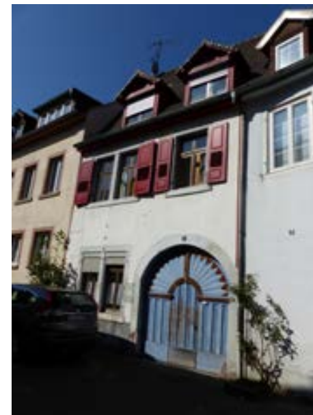
Karlsruhe-Durlach, Jägerstraße 7 v. NO
