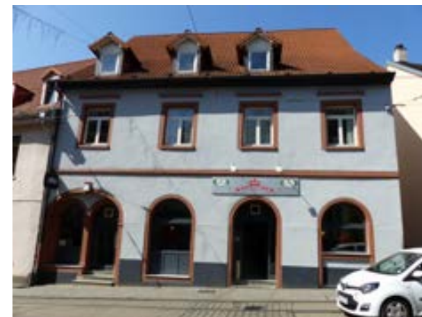
Karlsruhe-Durlach, Pfinztalstraße 8 v. S
