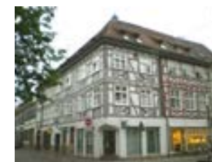
Eckansicht von Südwest
