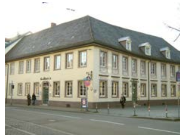
Karlsruhe-Durlach, Eckansicht von Ost
