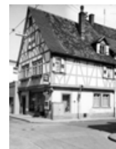
Fassade zur Mittelstraße, unverputzt
