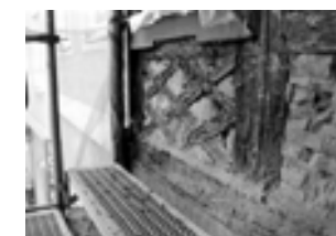
Freiliegendes Fachwerk
