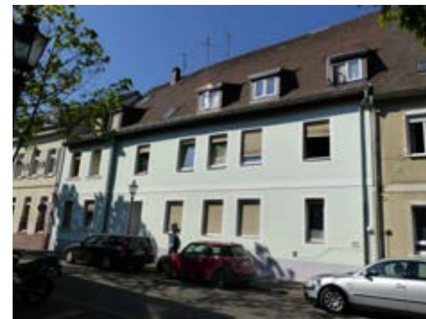
Karlsruhe-Durlach, Ochsantorstraße 11 v. NO
