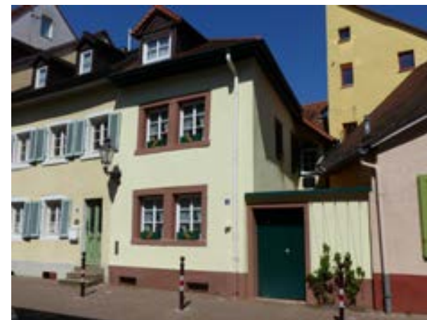
Karlsruhe-Durlach, Spitalstraße 8 v. SW
