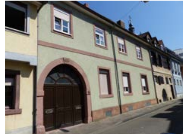
Karlsruhe-Durlach, Am Zwinger 14, v. SW
