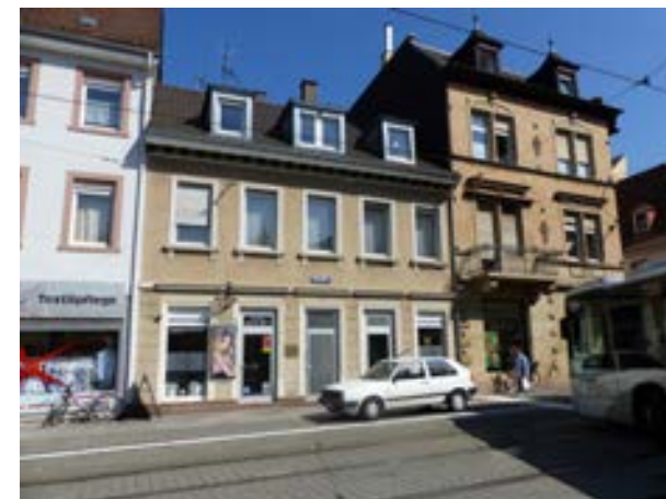
Karlsruhe-Durlach, Pfinztalstraße 14 v. S
