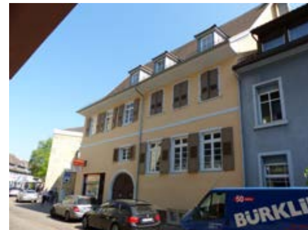
Karlsruhe-Durlach, Kelterstraße 1 v. SW
