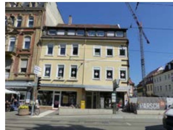
Karlsruhe-Durlach, Pfinztalstraße 30 v. S
