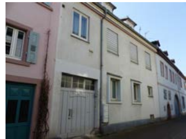
Karlsruhe-Durlach, Jägerstraße 21 v. NO
