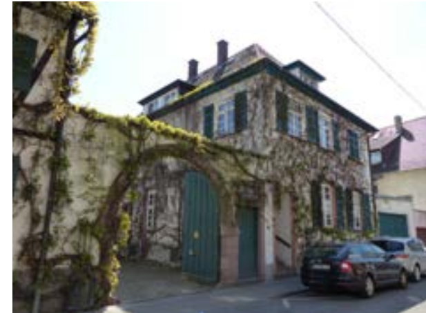
Karlsruhe-Durlach, Mittelstraße 11 v. NW
