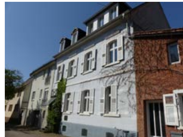
Karlsruhe-Durlach, Amthausstraße 28, v. NO
