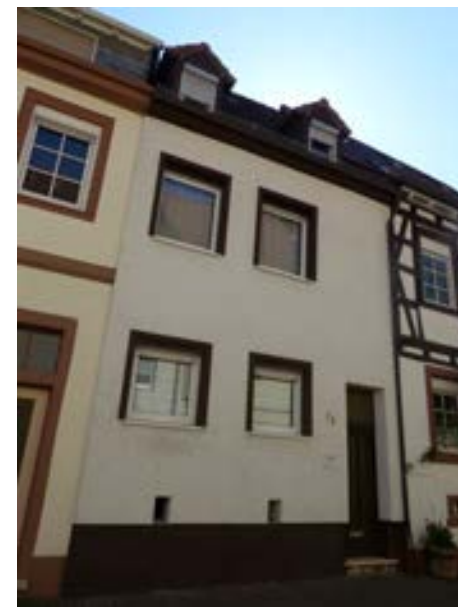
Karlsruhe-Durlach, Jägerstraße 34 v. NW
