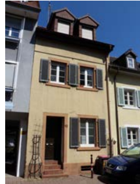
Karlsruhe-Durlach, Spitalstraße 12 v. SW
