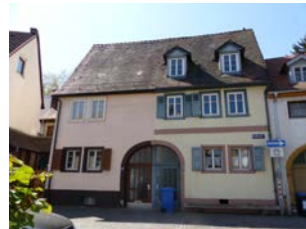
Karlsruhe-Durlach, Kelterstraße 26 u. 26a v. NO
