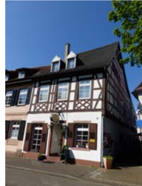
Karlsruhe-Durlach, Ochsantorstraße 17 v. NO
